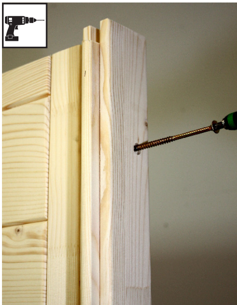
8 vis 6 x 120 mm par montant d'angle
