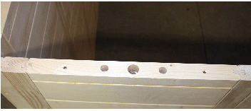
Elektroelement links - Abluft rechts hinten.
